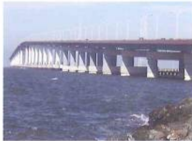
San Mateo Bridge, USA
